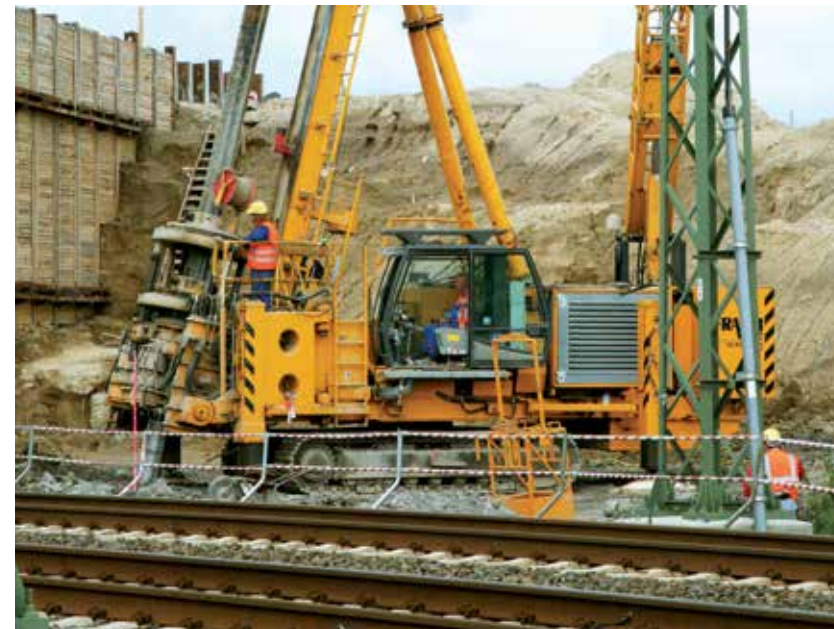
Autobahnbrücke über die Bahnstrecke Rostock-Berlin, bei Kavelstorf
