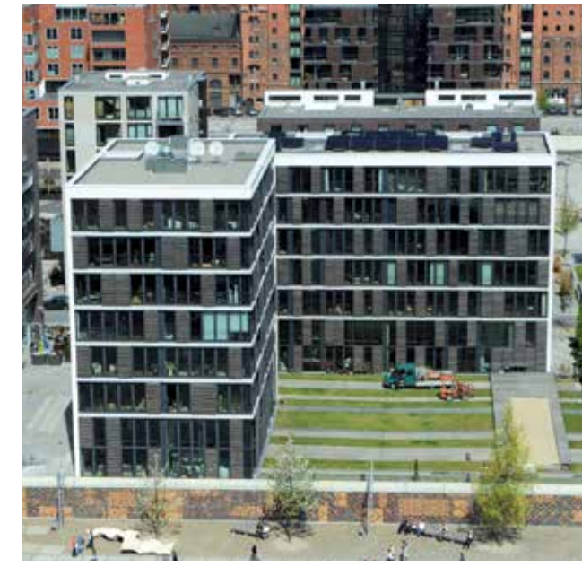
Wohngebäude, Hamburg HafenCity
