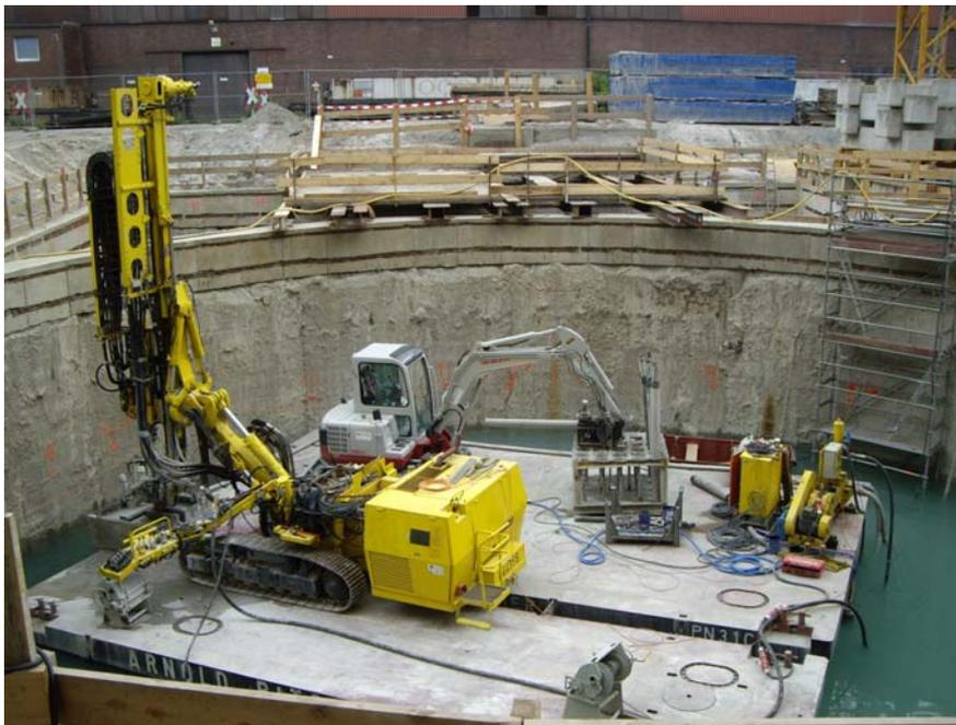
**Bild 7:** GEWI-Pfahlherstellung vom Ponton
