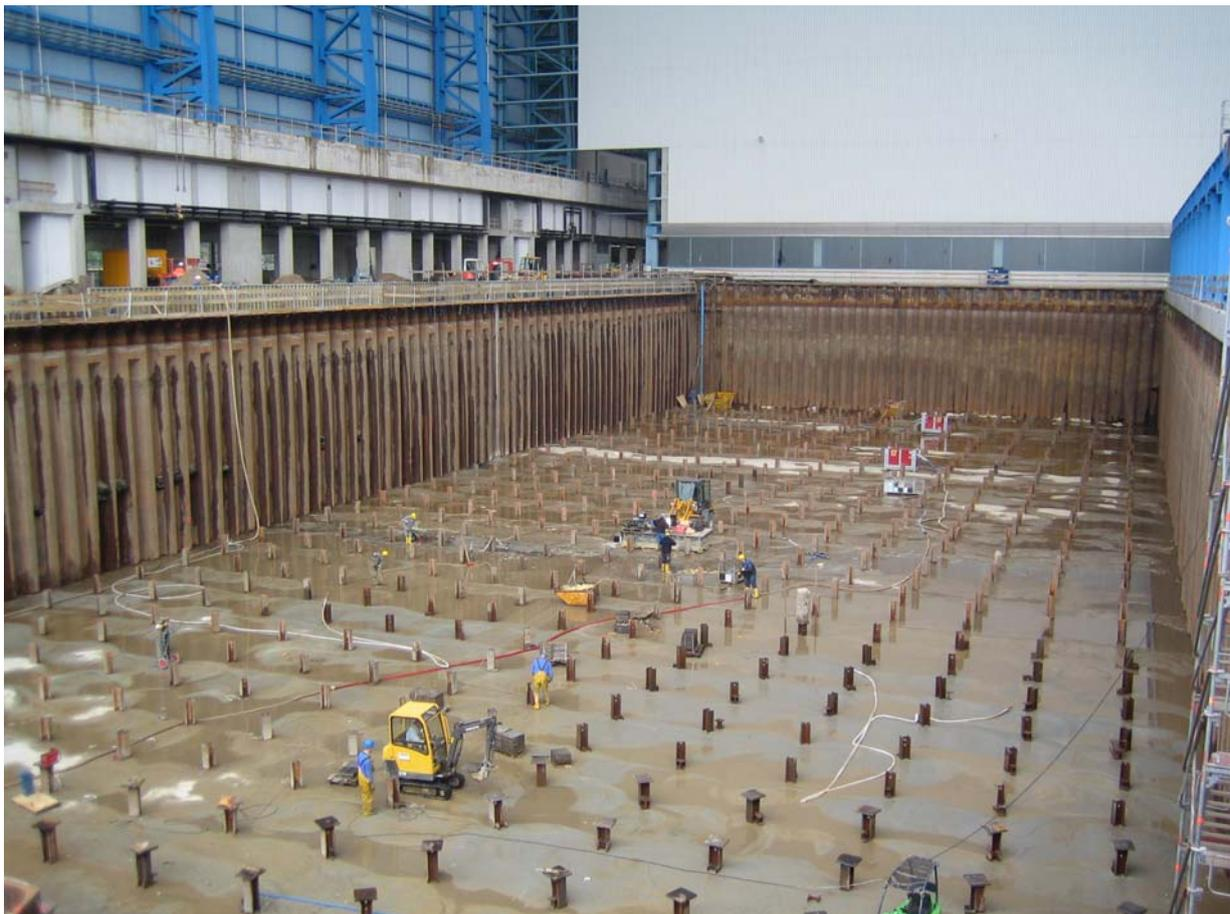
**Bild 11:** Blick auf die Unterwasserbetonsohle und die HEM-Profiltragglieder
