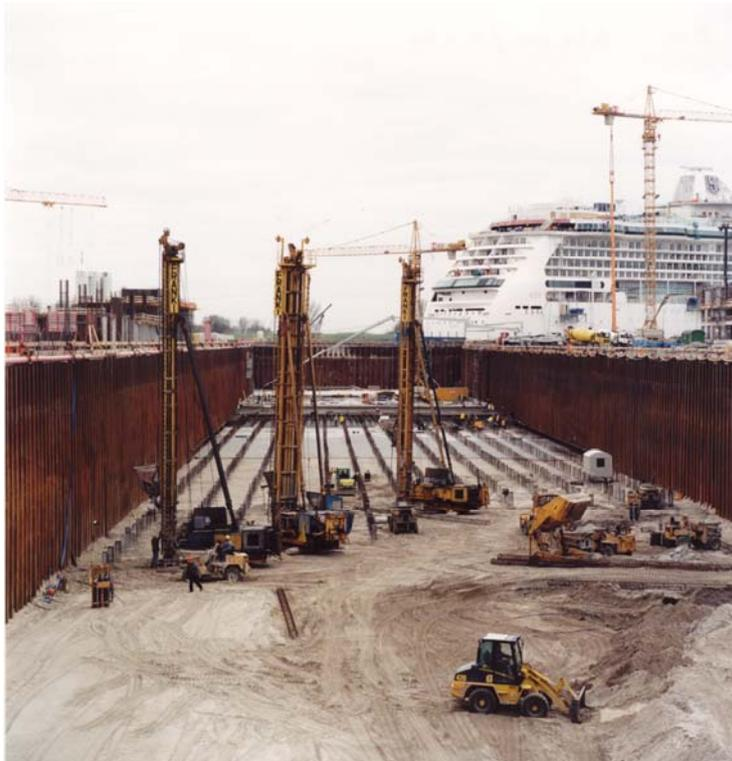
**Bild 2:** Rammarbeiten in der ausgehobenen Baugrube im Jahr 2000
