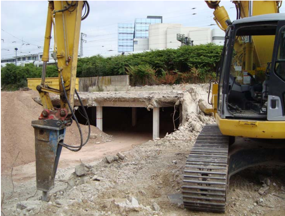
Bild 10: Kellerräume mit Verfüllmaterial
