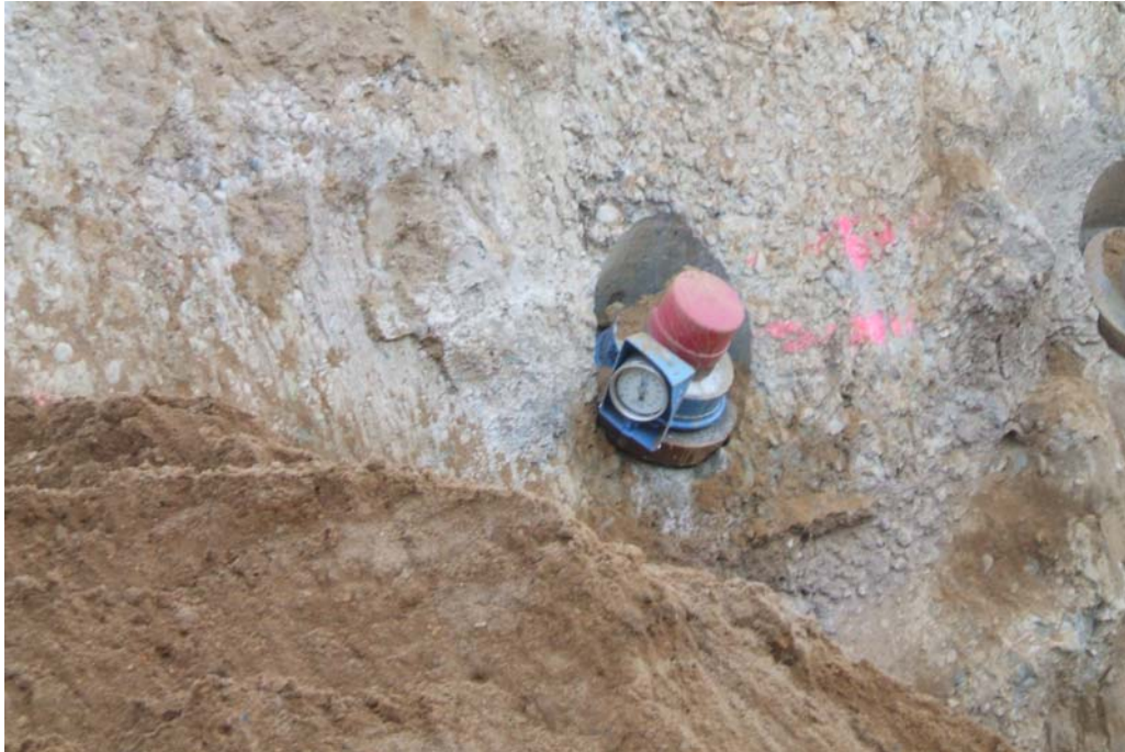
Bild 5: Ankerkopf mit Kraftmessdose
