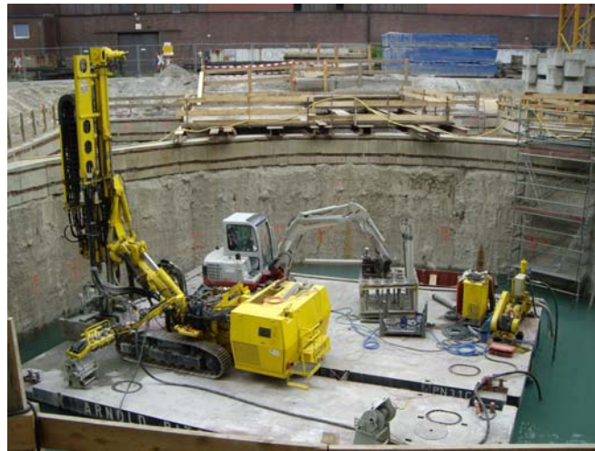
Bild 10: Auftriebspfahlherstellung für Sinterbrunnen
