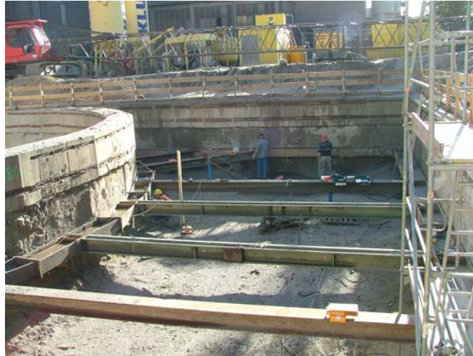
Bild 7: Kopfbalken mit Anschlüssen für den späteren an das Bauwerk
