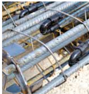
Pfahlbewehrungskorb mit Geothermieleitungen
