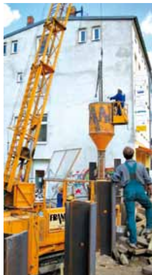
Einbau des Bewehrungskorbes beim Atlaspfahl
