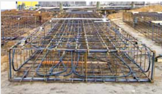
Schlitzwandkorb mit Geothermieleitungen
