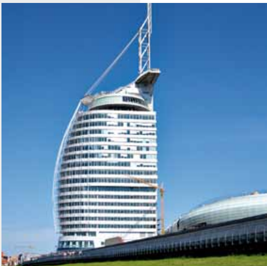
Sail City, Bremerhaven: Tiefgründung mit Franki-, Simplex- und Atlaspfählen mit geothermischer Nutzung
