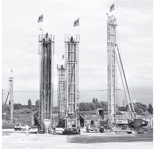
Blick auf das Baufeld
