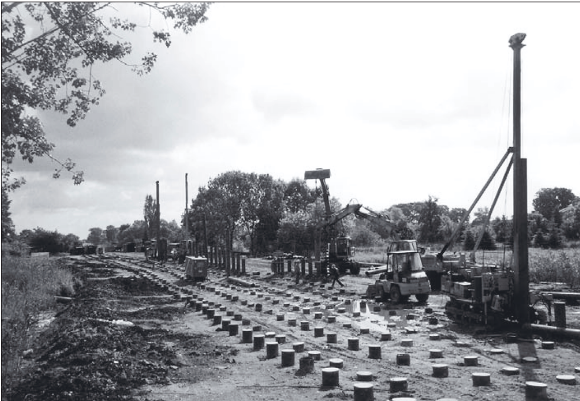
Bild 9: Pfahlherstellung auf der Baustelle
