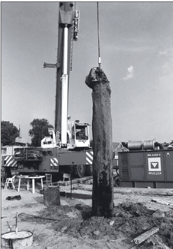
Bild 16/17: Freigelegte ORS mit Geotextilhülle
