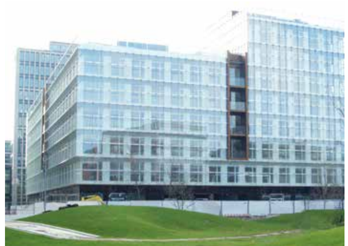
Bürogebäude Commercial Center, Hamburg
