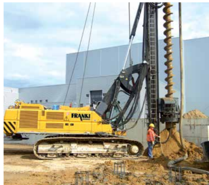
Hochregallager Übach-Palenberg: Herstellung SOB-Pfahl
