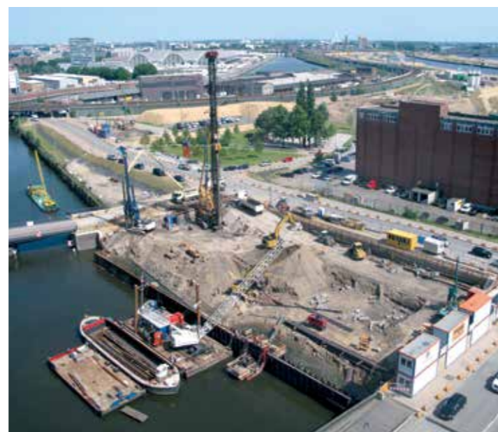
Bürogebäude Marquard & Bahls, HafenCity Hamburg: Hindernisbohrungen und Pfahlherstellung
