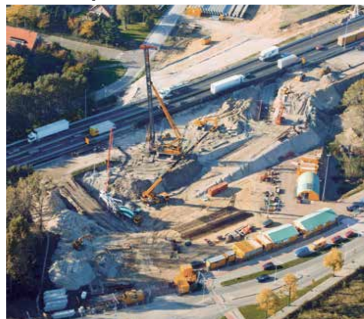
Unterführung der Autobahn A 2, 64 VB-Pfähle für jede Brückenhälfte
