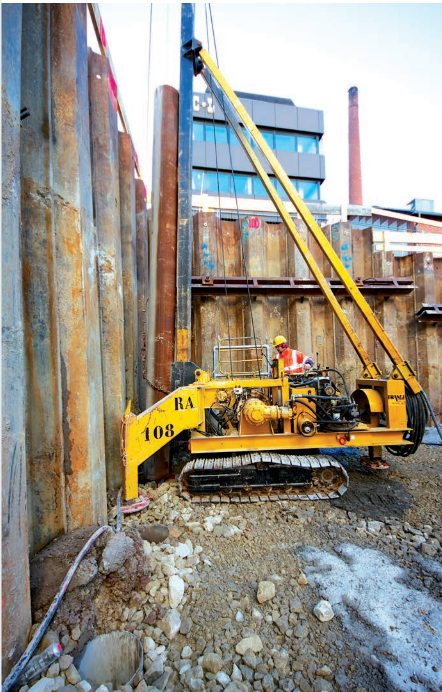
Met een kleine heimachine kunnen ook in krappe omstandigheden stalen buispalen gemaakt worden
