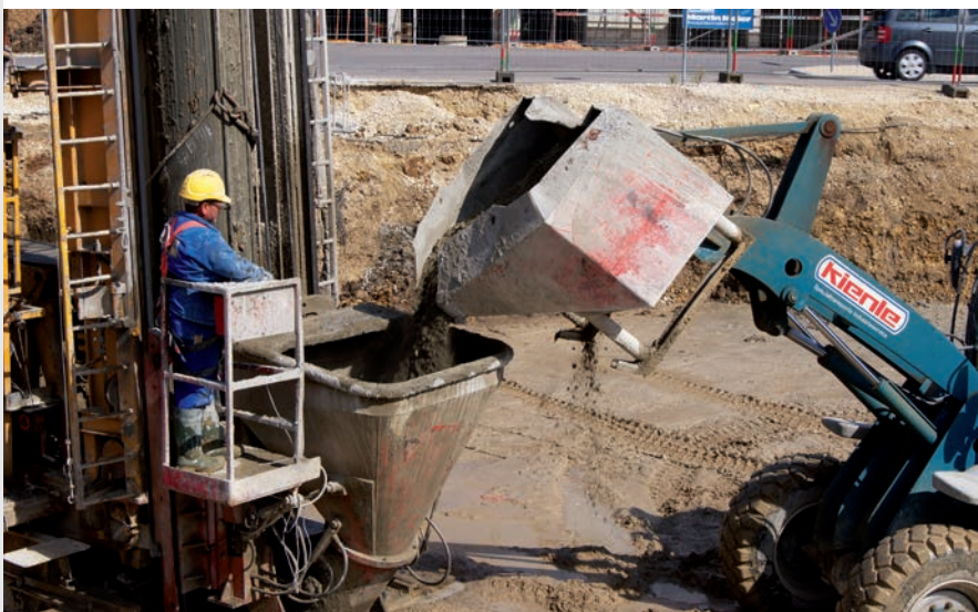
De betonkubel wordt gevuld met vers beton voor de paalschacht
